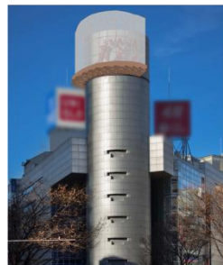
作業中（安全幕を設置）
