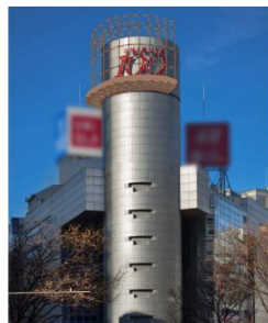
作業していない日中
